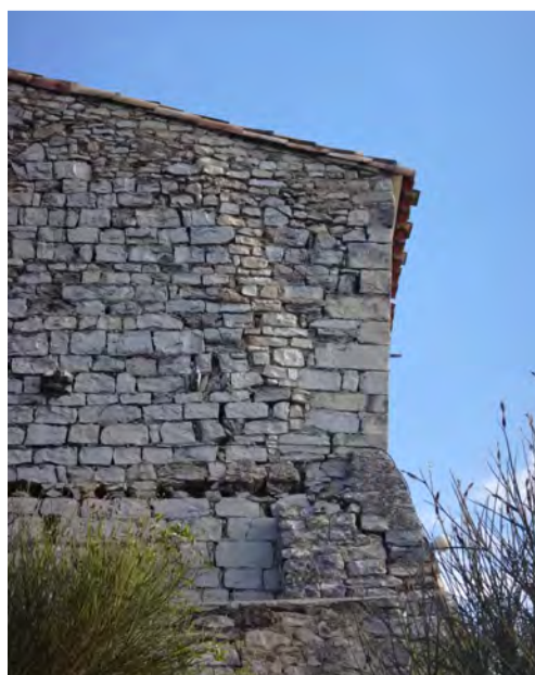
Vue du pignon Est
