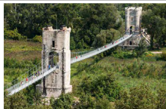
Vieux Pont restauré, 2013
